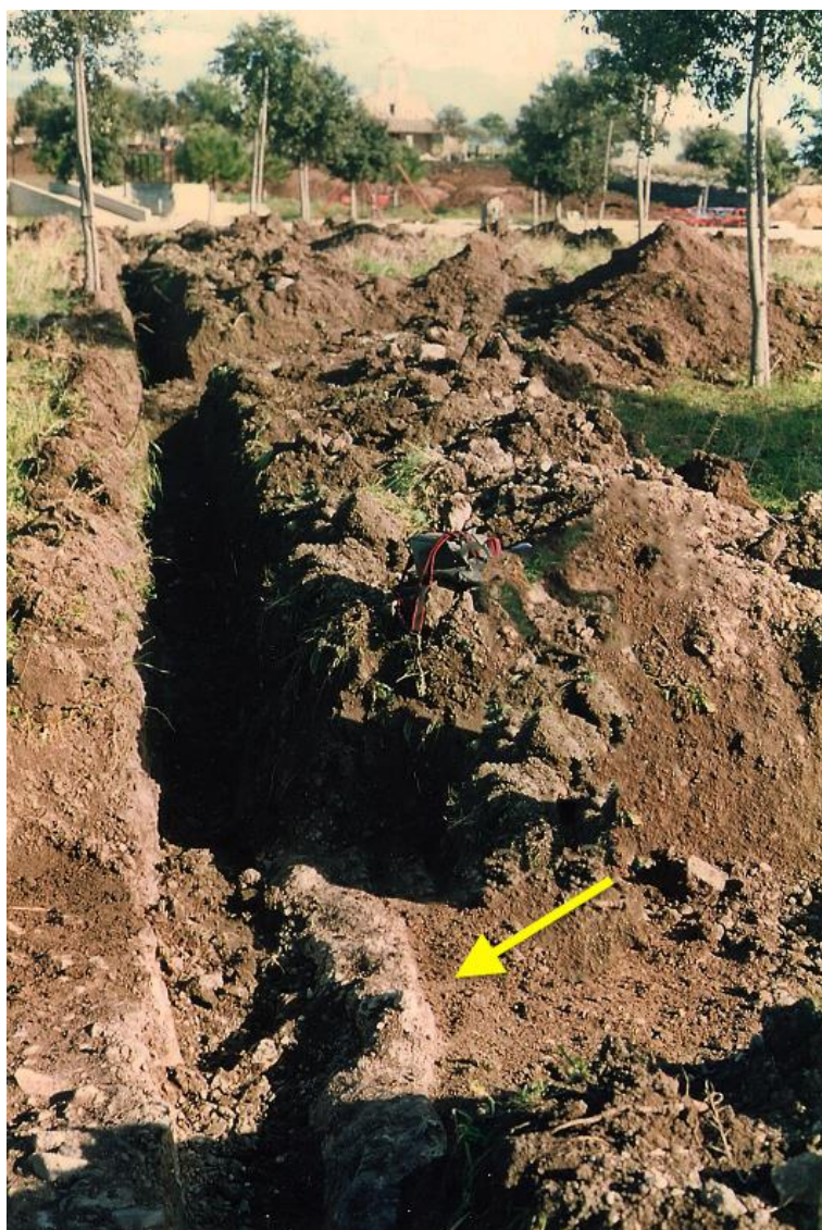
Fig. 10: MONASTIR - Loc. Santa Lucia. La struttura canalizzata in opera cementizia emersa durante i lavori (da SW) (foto d'archivio).
