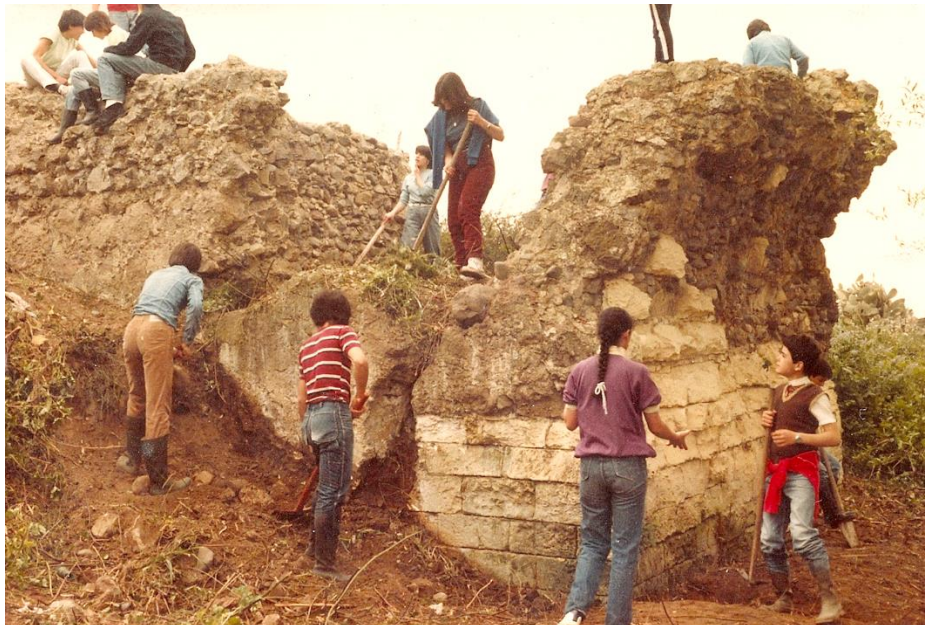
Fig. 17: MONASTIR - Loc. Ponti Becciu . Veduta del ponte romano alla fine degli anni Settanta del Novecento (da SW) (foto S. Atzeni).
