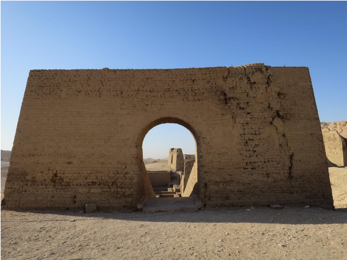
Fig. 3: Pilone d'ingresso della tomba (foto S. Einaudi).
