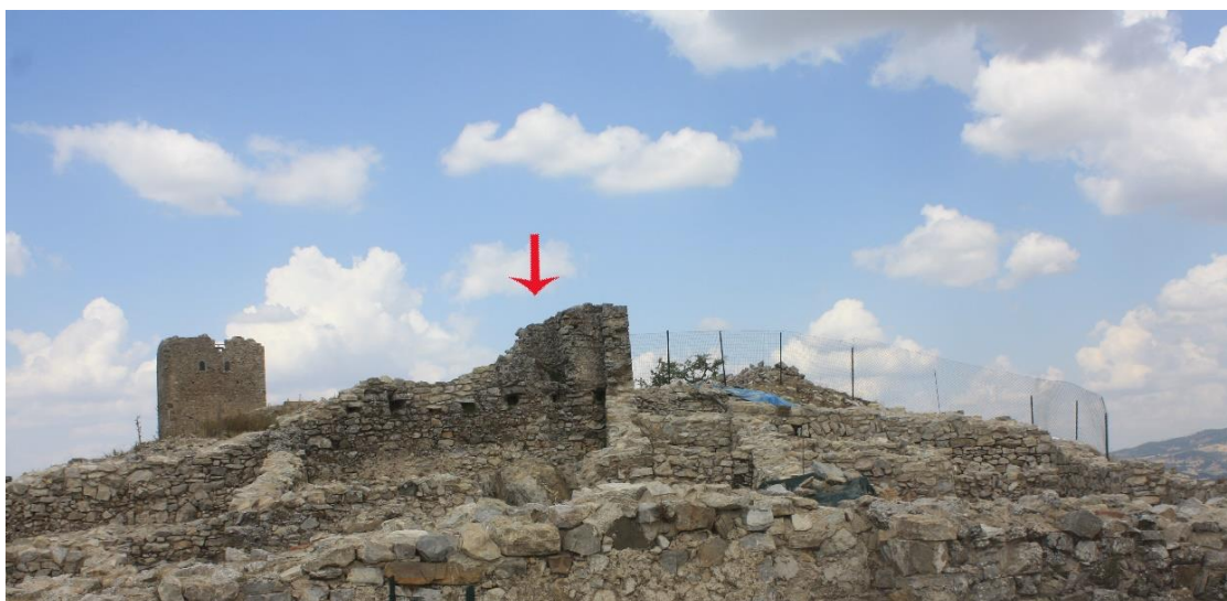
Fig. 11: TTTO- Loc. Satrianum – Complesso episcopale, traccia di un camino al primo piano (foto B. Gargiulo).
