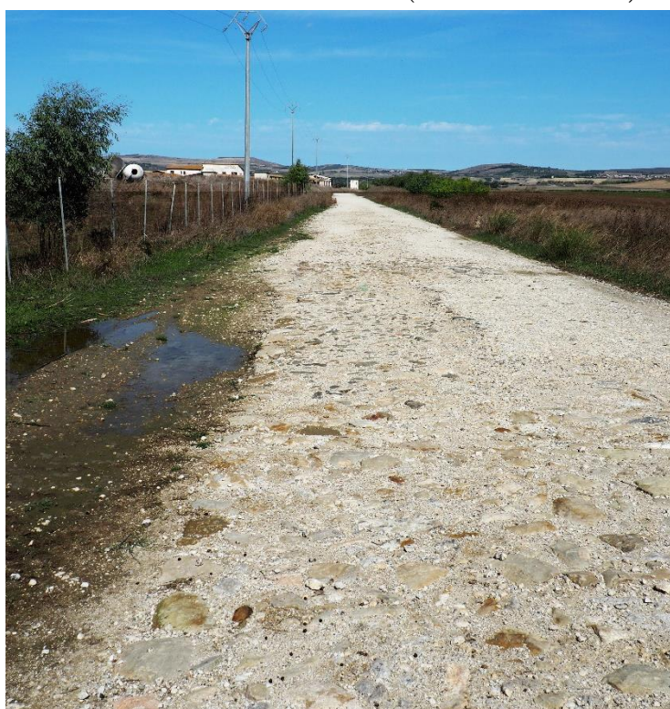
Fig. 17: ORTACESUS - Tracciato 3, settore 2, PT 3.2 (foto D. D'Orlando).
