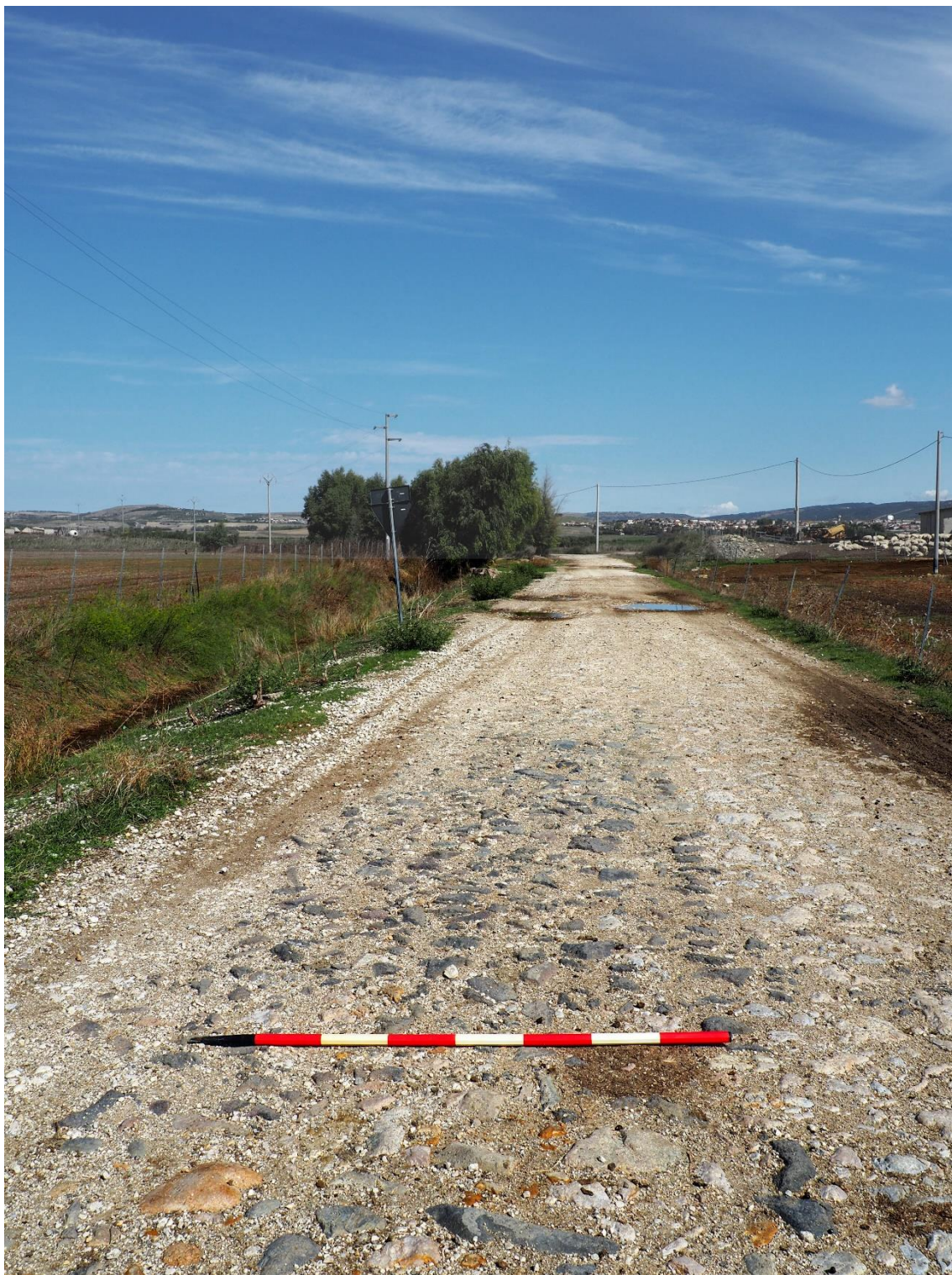
Fig. 18: ORTACESUS - Tracciato 3, settore 2, PT 3.3 (foto D. D'Orlando).
