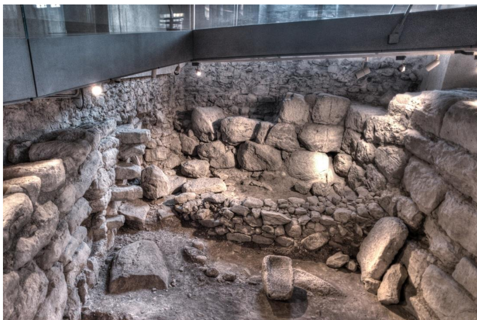
Fig. 7: Il cortile compreso tra l'antemurale, a sinistra, la cortina sud-est a destra e la torre sud sullo sfondo. Nel paramento murario dell'antemurale è visibile la scala realizzata con lastroni infissi nella muratura.
