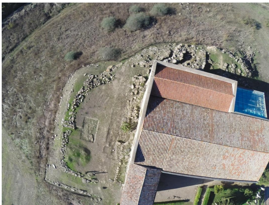
Fig. 6: La torre di nord-ovest da un punto di osservazione zenitale.
