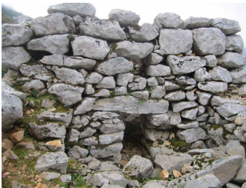
Fig. 1: BAUNEI - Nuraghe Co 'e serra. Struttura rettangolare
