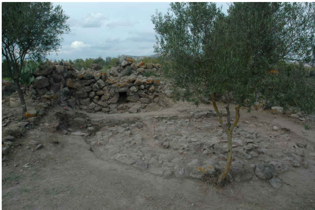
Fig. 2: SAN GIOVANNI SUERGIU – Loc. Candelargiu. Vista generale del prospetto est del nuraghe nella quale si osserva l'ingresso e la struttura di pianta circolare documentada frontalmente ad essa.
