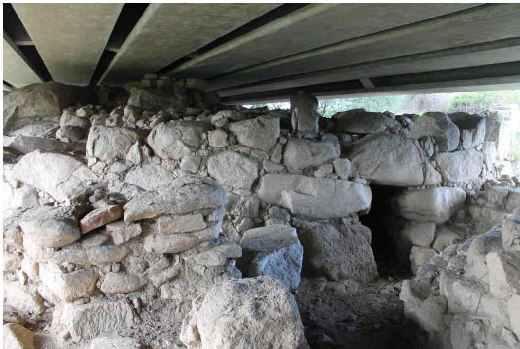
Fig. 1: OLBIA – Loc. Belveghile. Ingresso Torre B
