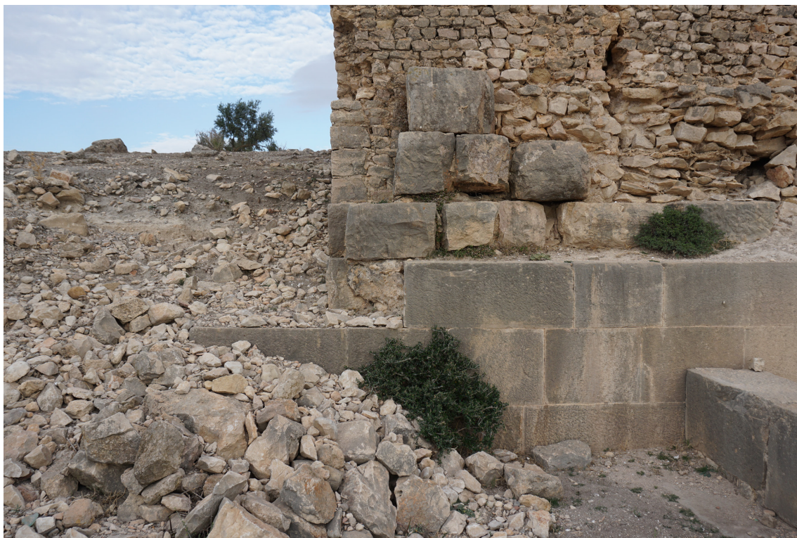
Fig. 3. Particolare del rapporto tra il muro settentrionale dell' aditus e quello semicircolare che delimita la cavea.
