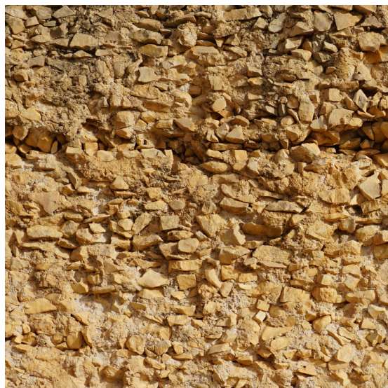
Fig. 13. Particolare del paramento interno del muro semicircolare.
