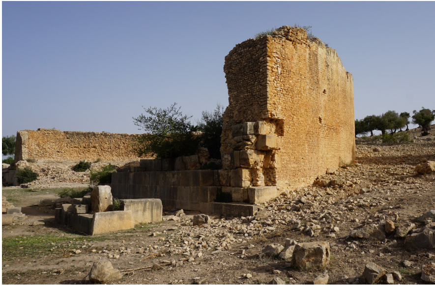
Fig. 25. Angolo meridionale muro semianulare. Sono evidenti le tracce in negativo dei blocchi riconducibili alla muratura dell' aditus .
