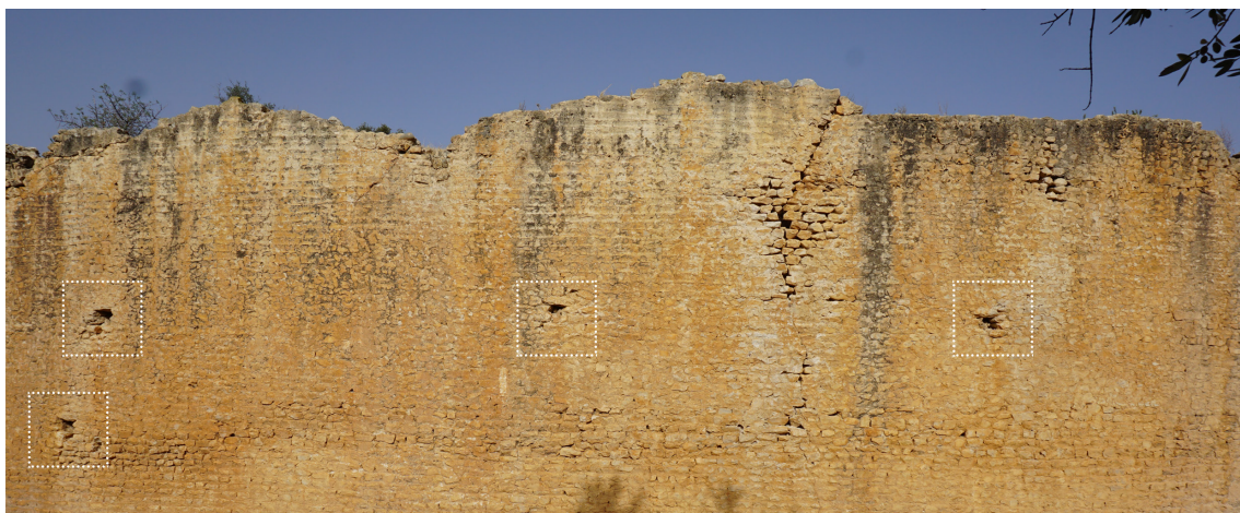
Fig. 14. Veduta del paramento esterno del muro semicircolare (settore meridionale). I quadrati bianchi, in tratteggio, indicano i fori presenti sulla muratura, probabilmente riconducibili a fori da ponte e tracce di cantiere.
