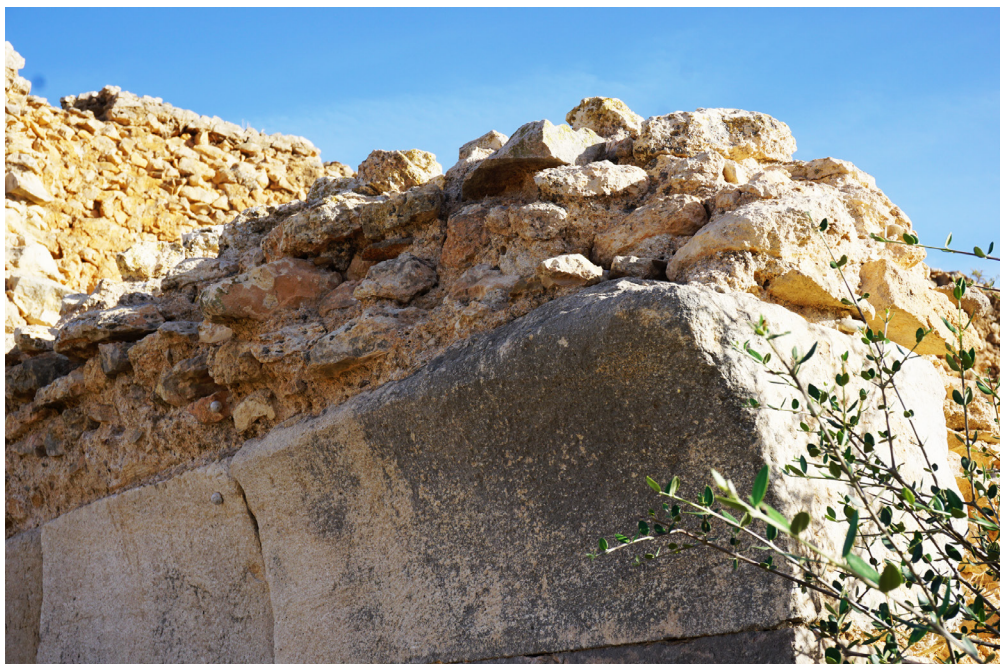
Fig. 6. Particolare del muro in opera quadrata e della lavorazione dei blocchi per il piano di imposta della copertura in caementicium .
