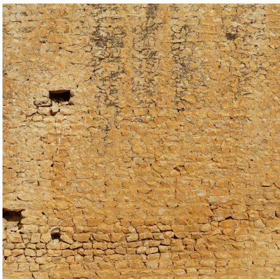
Fig. 12. Particolare del paramento esterno del muro semicircolare.
