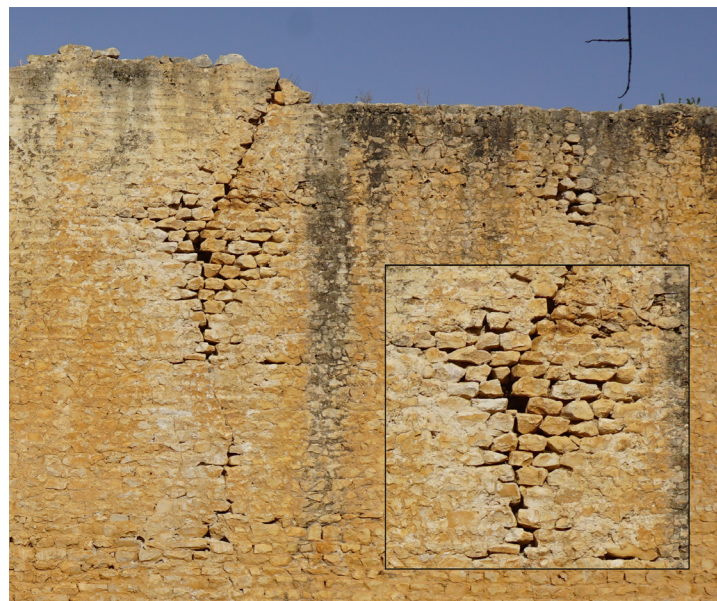
Fig. 24. Settore meridionale del muro semicircolare. La traccia individuata suggerisce un giunto murario, probabilmente riconducibile alle fasi di costruzione del muro.
