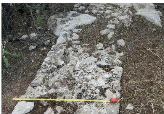
Fig. 10 B. Thignica . Muro di contenimento sulle pendici occidentali del Djebel Tounga (foto A. Mosca).
