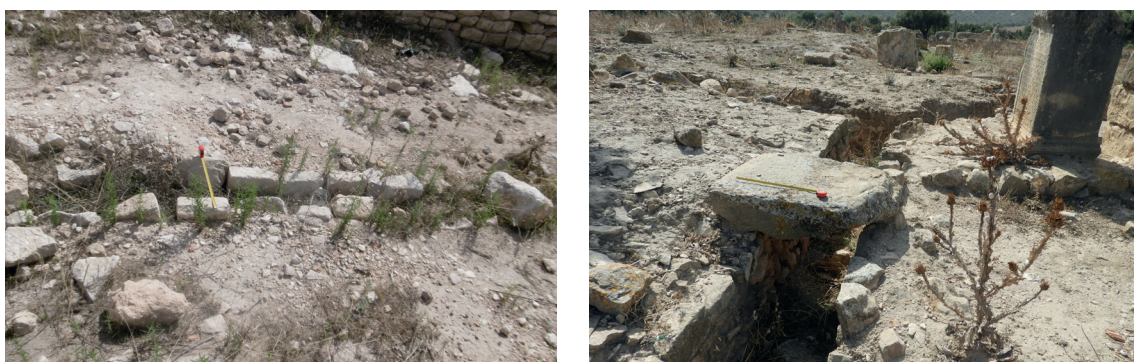
Fig. 15 a-b. Thignica . A. Canalizzazione sotto il basolato stradale (foto A. Mosca); B: Canalizzazione in direzione sud-ovest (foto A. Mosca).
