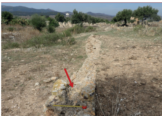
Fig. 11 D. Thignica . Segmento di condotta idrica: particolare della canalizzazione (foto A. Mosca).
