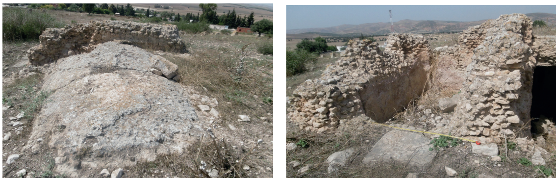
Fig. 14 a-b. Thignica . Struttura crollata a nord-est della fortezza (foto A. Mosca).
