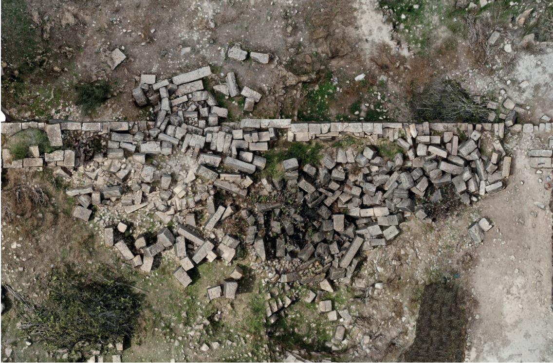
Fig. 11. Il crollo del muro W della fortezza (ortofoto di Salvatore Ganga).
