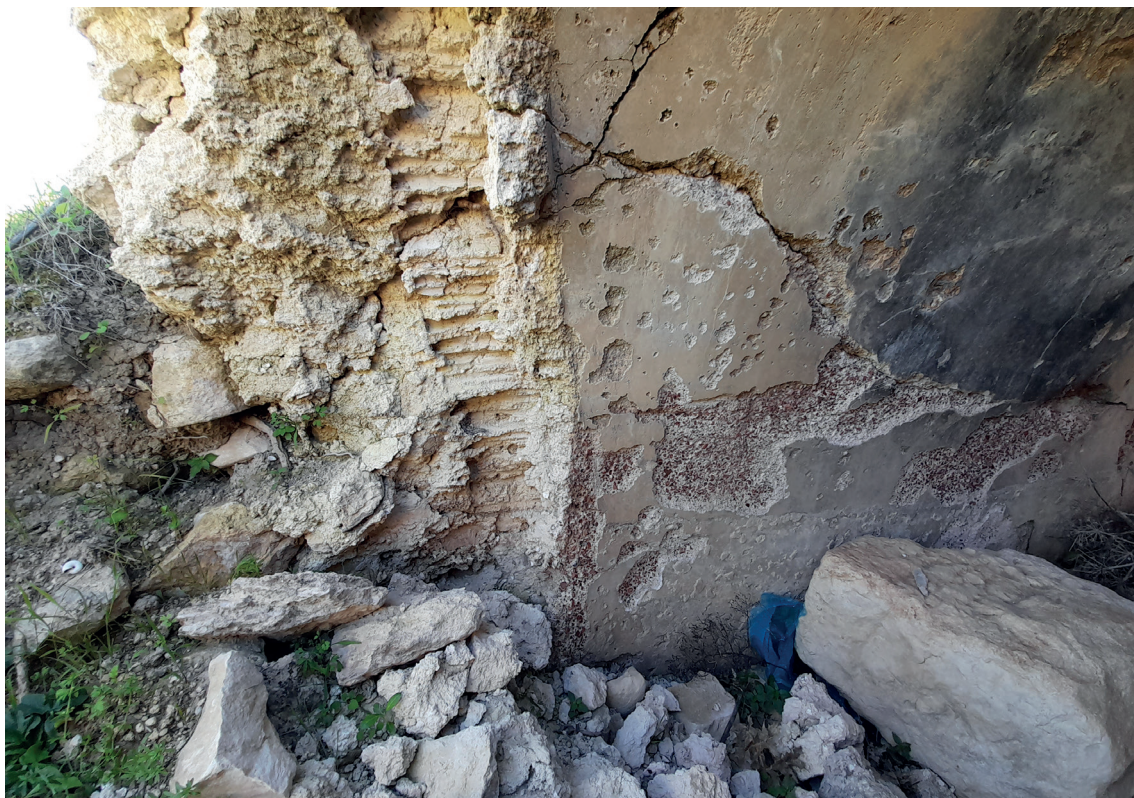
Figure 6. Détail montrant les traces du coffrage.
