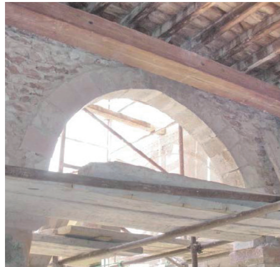
Fig. 38. Vue de l'intérieure façade ouest en cour d'intervention.
