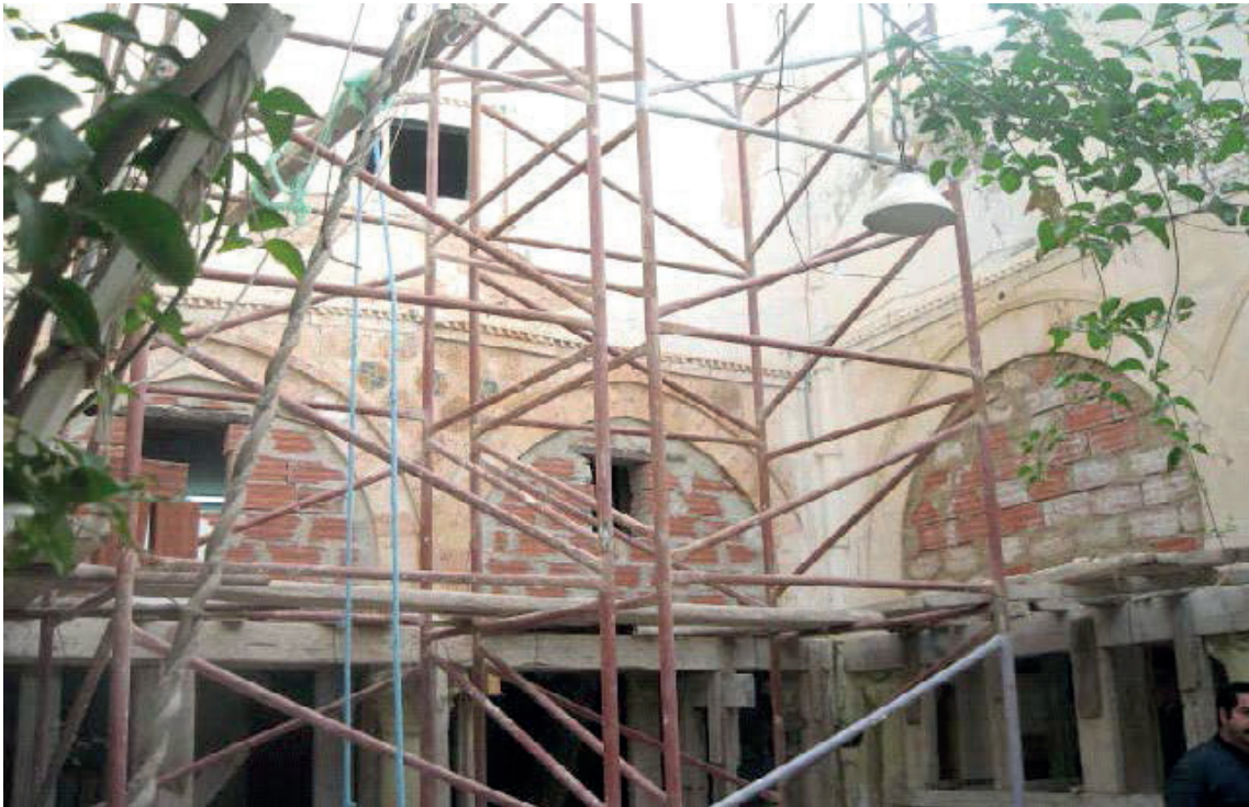
Fig. 25. Travaux d'étalement de la façade, des planchers du portique et de la ghorfa...).
