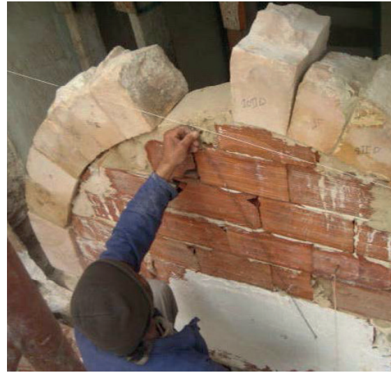
Fig. 36. Traçage sur le coffrage.
