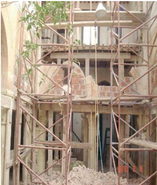
Fig. 29. Démontage de la façade ouest.
