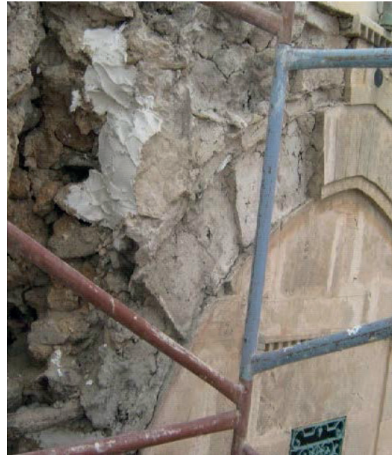
Fig. 30. Démontage de la façade est.
