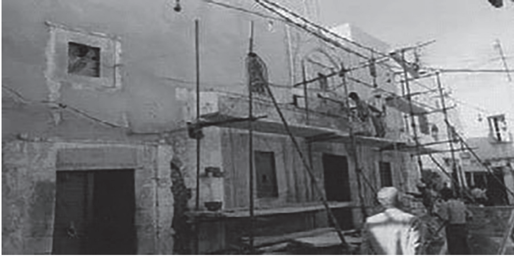
Fig. 11. Travaux exécutés en 1994 sur la façade principale.
