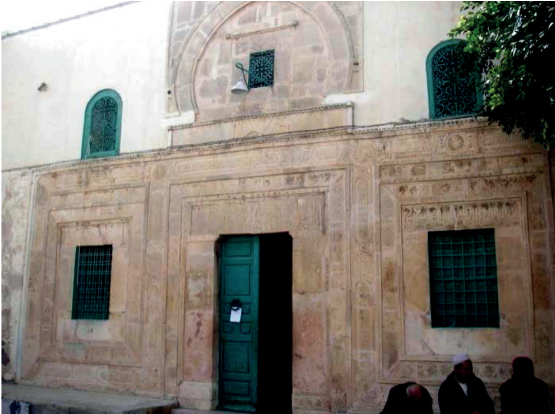
Fig. 3. Façade la zaouïa
