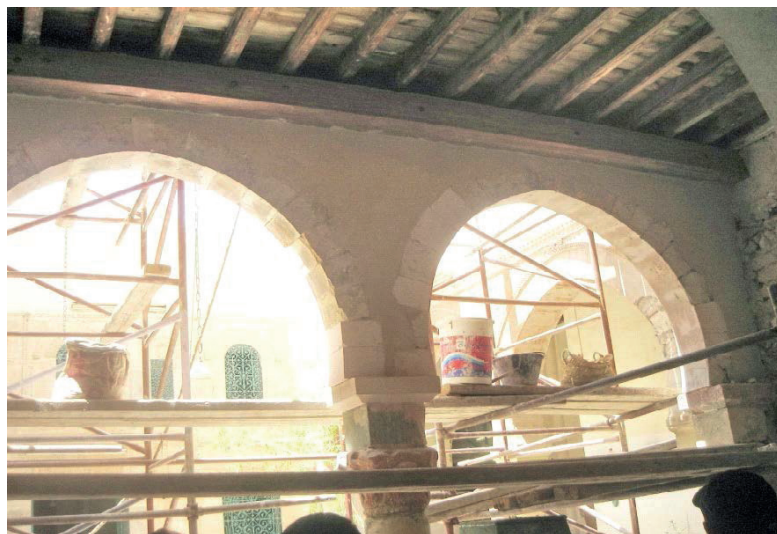
Fig. 39. Vue de l'intérieur après l'intervention.
