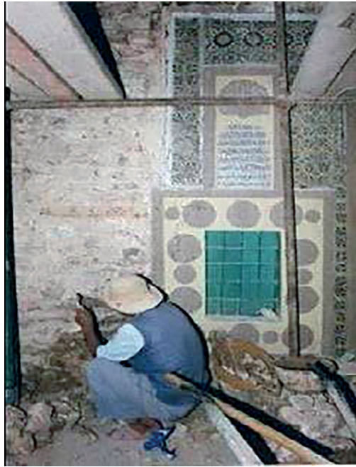
Fig. 12. travaux exécutés à l'intérieur.
