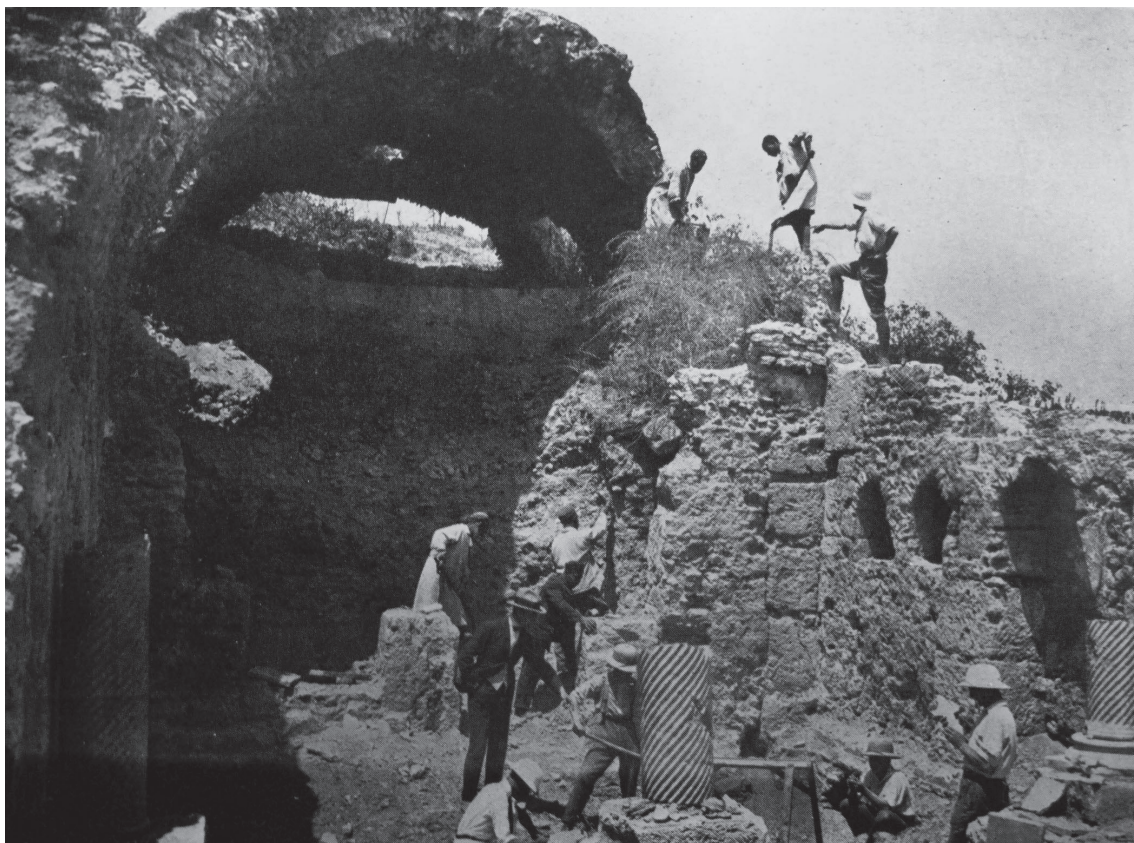
Fig. 1. Excavación de Khun de Prorok en la colina de Juno. Khun de Prorok (1923a).
