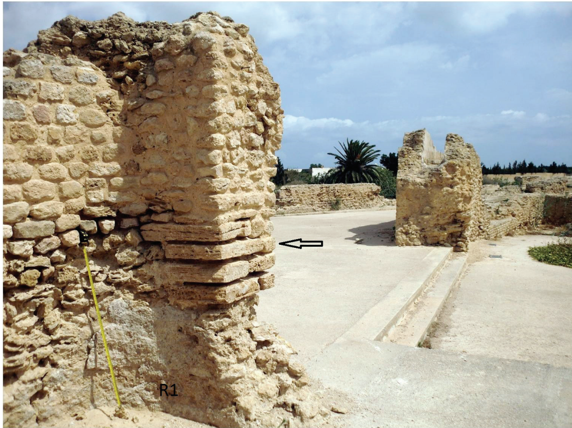
Fig. 13a. Débouché du canal d'alimentation en eau du monument hydraulique dans R1 (indiqué par la flèche).
