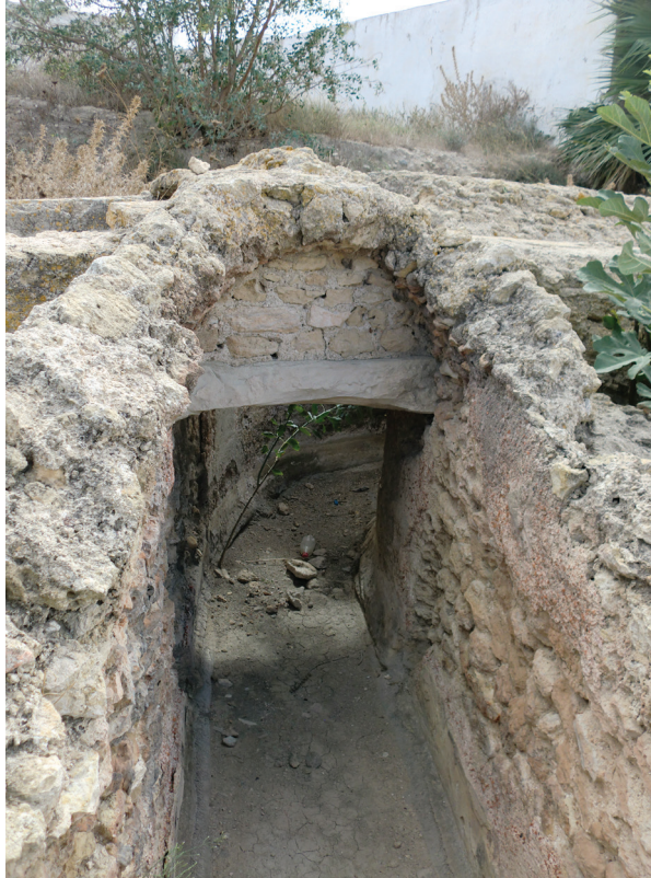
Fig. 3b. Dalle-pont étendue sur les piédroits du specus de l'aqueduc de Carthage préservant la petite conduite.
