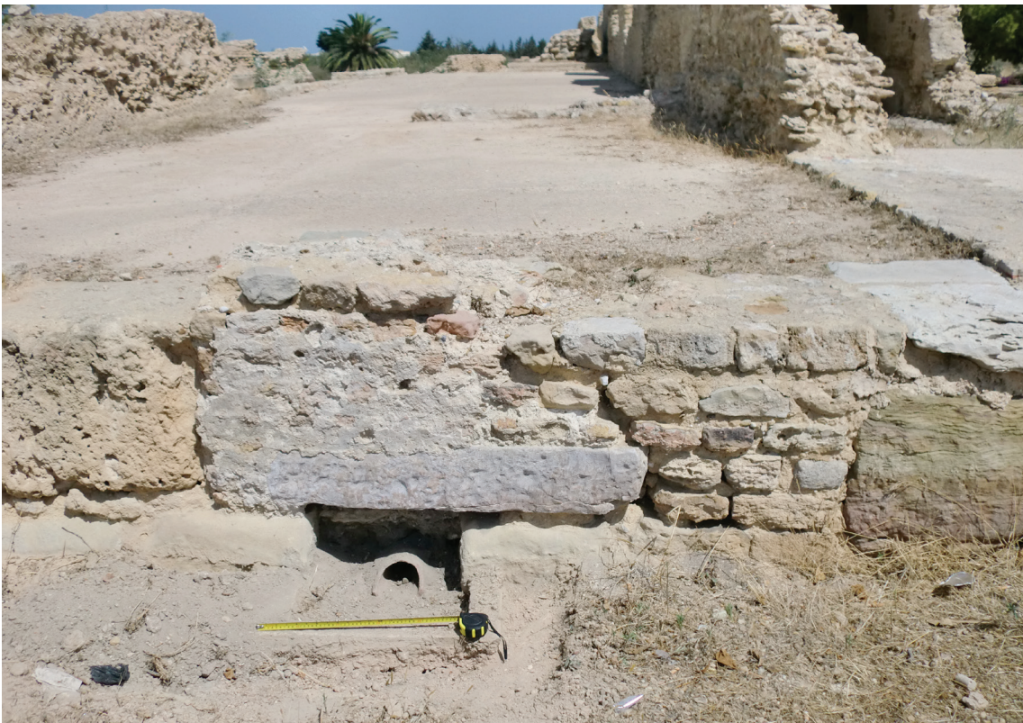
Fig. 18b. Tube d'évacuation des eaux usées du nymphée.
