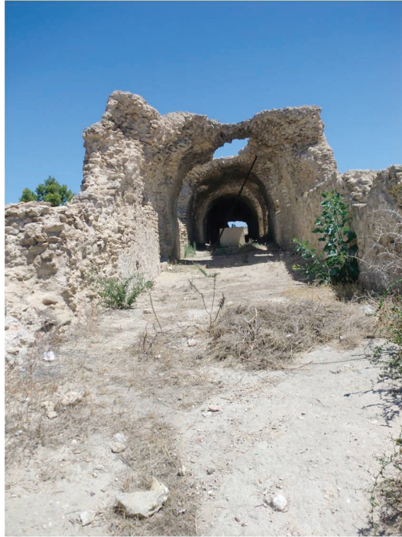
Fig. 6a. Etat de conservation de R3 (vue vers le nord).
