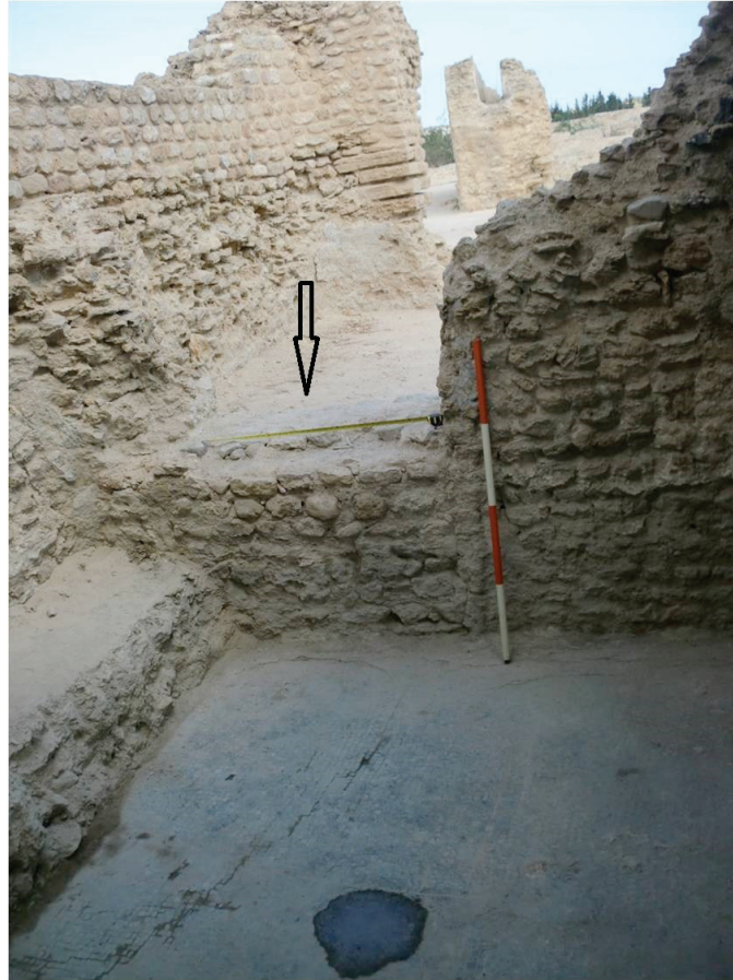
Fig. 9a. Sondage dans R2 au niveau de la porte de communication avec R1.
