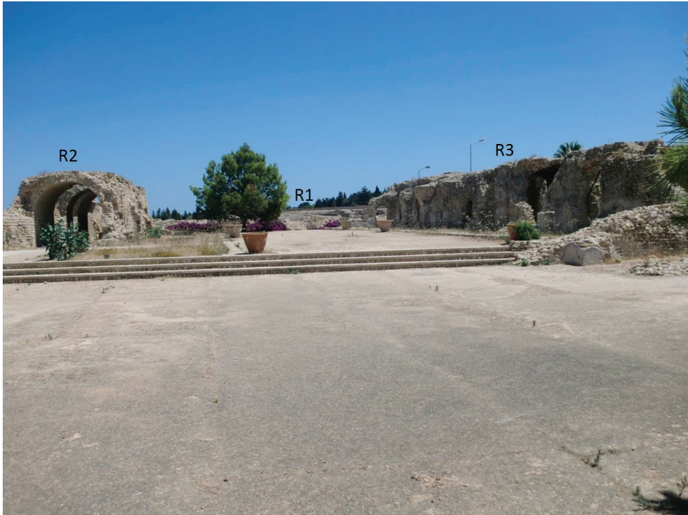
Fig. 5a. Vue vers le nord de l'ensemble hydraulique monumental en U. L'accès.
