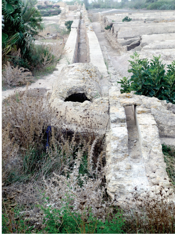
Fig. 3a. Petite conduite à l'angle sud-est des "Citernes de La M'alga".
