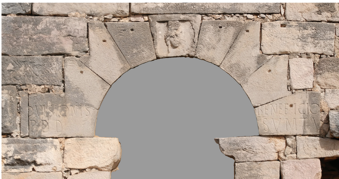
Fig. 19. Dettaglio dell'arco che copre l'apertura della torre. Foto S. Ganga.
