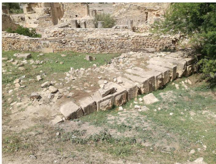
Fig. 6. Terme di Thignica : lo spesso muro con paramenti in blocchi di reimpiego a sud dell'edificio. Foto A. Teatini.
