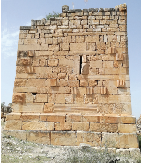
Fig. 4. La torre nord-orientale del forte: risalta il reimpiego di numerosi elementi architettonici. Foto A. Teatini.
