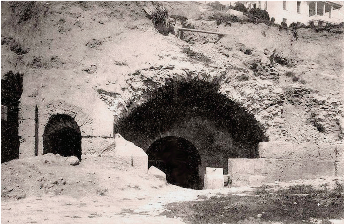
Fig. 4. La façade de la « Fontaine aux 1000 amphores » vers 1930, déjà précédée d'éboulements récents venus d'en haut. Au premier plan, vestiges de la façade ultime [8]. En peu en arrière, dans l'ombre, on distingue l'arc de la porte de la façade antérieure [6]. Noter une construction moderne en haut et à droite du cliché.
