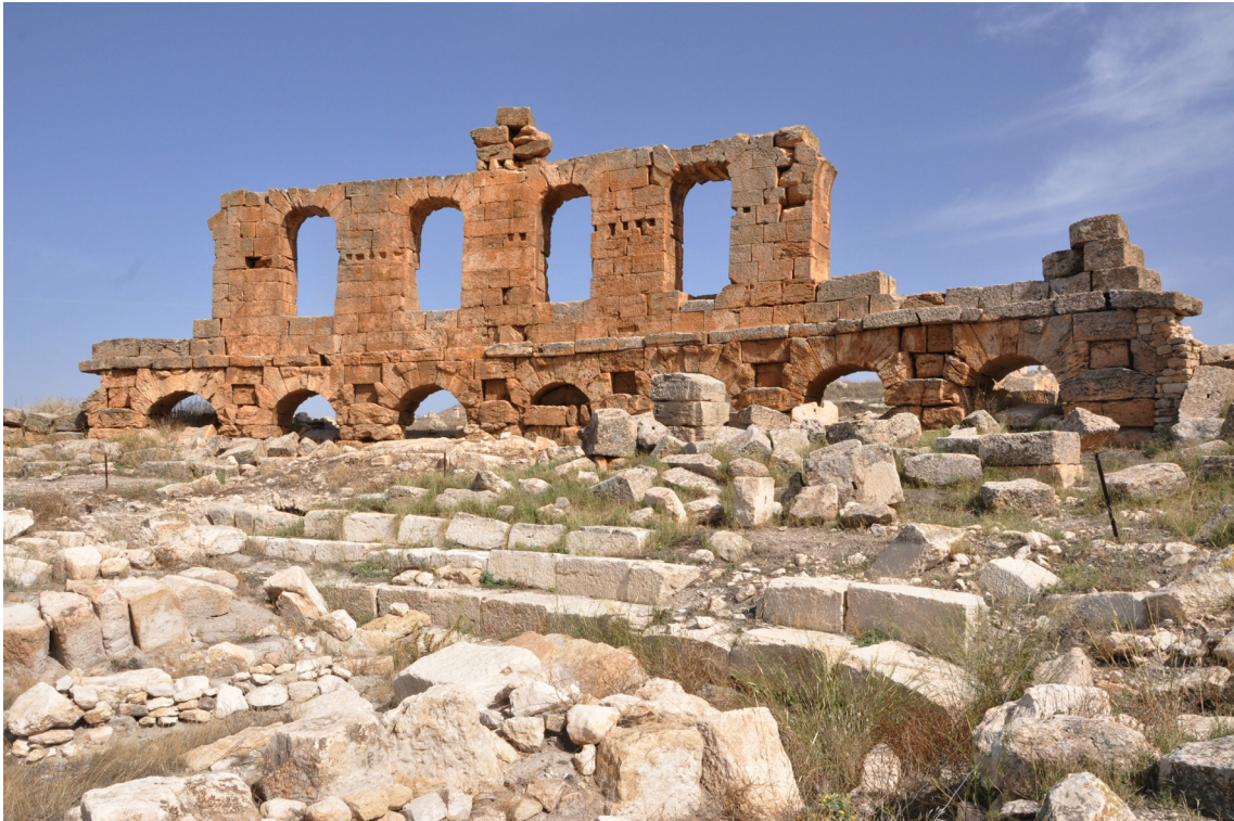
Fig. 1. Althiburos . Teatro. Veduta della parte orientale della cavea e del muro perimetrale, da Sud Ovest. Ottobre 2014.
