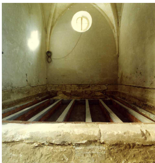
Fig. 21. Cappella della Grazie. Lavori di restauro (foto archivio Soprintendenza Beni A.P.S.A.E.).
