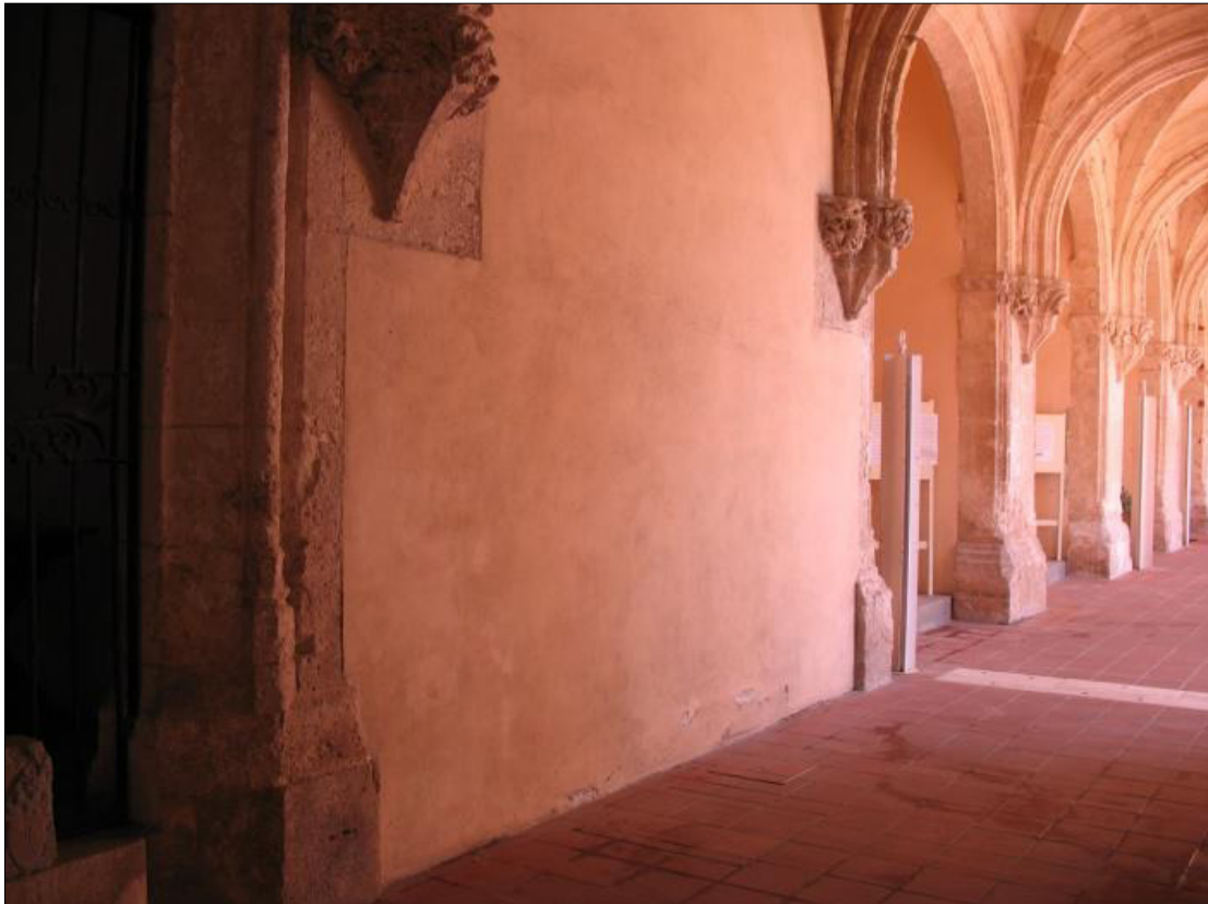
Fig. 4. Cappella "A" del chiostro, braccio ovest (foto M. F. Porcella).
