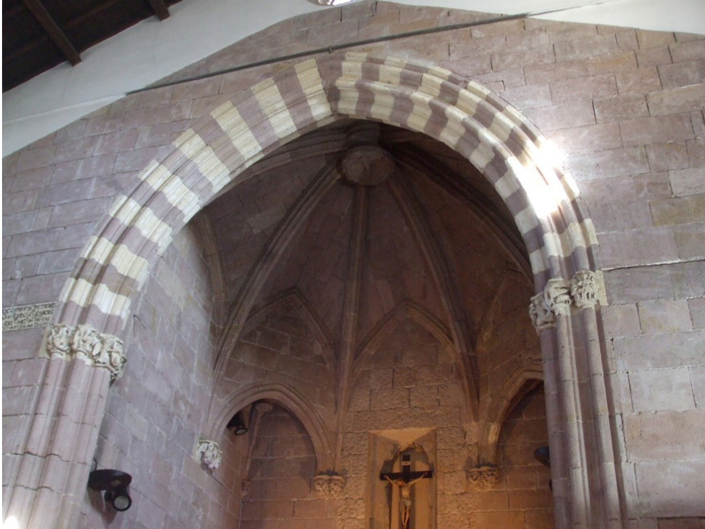
Fig. 3. Le prime applicazioni moderne delle scuffie, in Sardegna, sono al servizio di piccoli ambienti quadrilateri, come presbiteri o cappelle, coperti da crociere poligonali. Gli elementi costruttivi raccordano due forme altrimenti incompatibili. Due interessanti esempi si trovano nella chiesa di San Francesco ad Iglesias.
