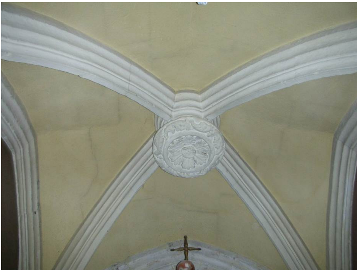
Fig. 1. Villacidro, chiesa parrocchiale S. Barbara: volta della prima cappella a sinistra.
