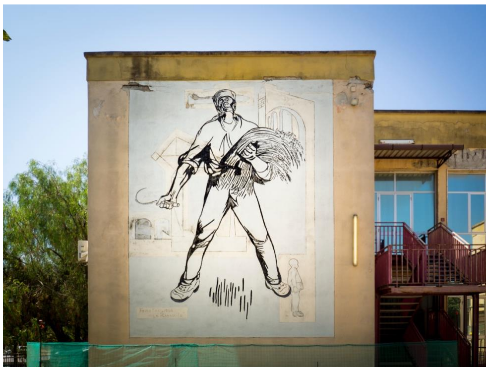
Fig. 6. Dettaglio prospetto ante lavori, da relazione restauro, Archivio corrente comune di Sinnai.
