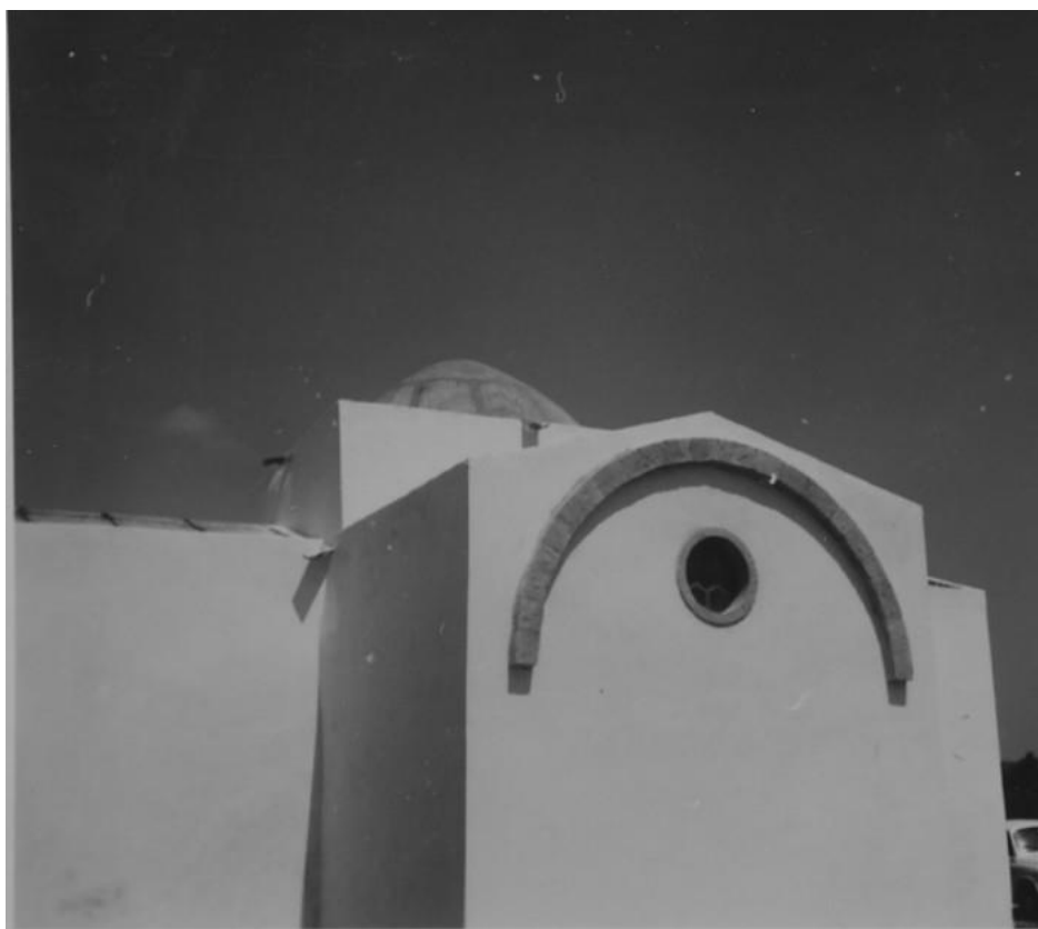
Fig. 4. Chiesa San Teodoro di San Vero Congius, dopo il primo restauro, braccio Est, Simaxis, 1963 (su gentile concessione della Pro Loco del Comune di Simaxis).
