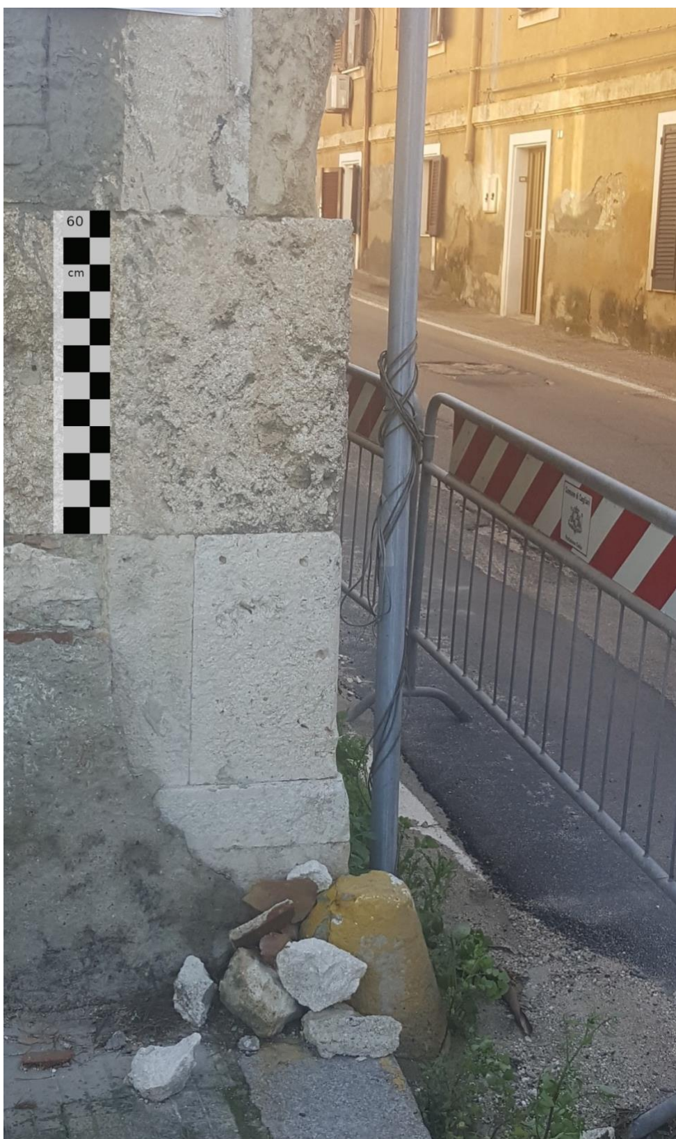
Fig. 6. Cagliari, Tracce della parasta angolare della chiesa inglobate nell'attuale costruzione.
