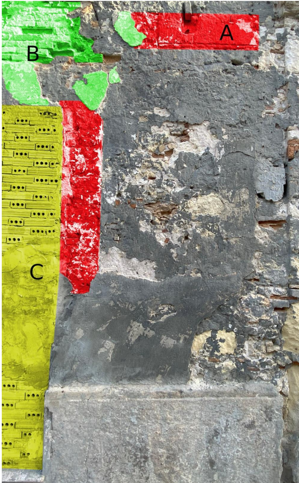
Fig. 5. Cagliari, Analisi di un tratto murario dell'attuale edificio. Si evidenzia in rosso (A) la possibile traccia dell'originale portale. Con il colore verde (B) sono indicati gli intonaci sovrapposti e le integrazioni di inizio '900. Infine, col colore giallo (C) le tamponature più recenti risalenti agli ultimi quarant'anni.
