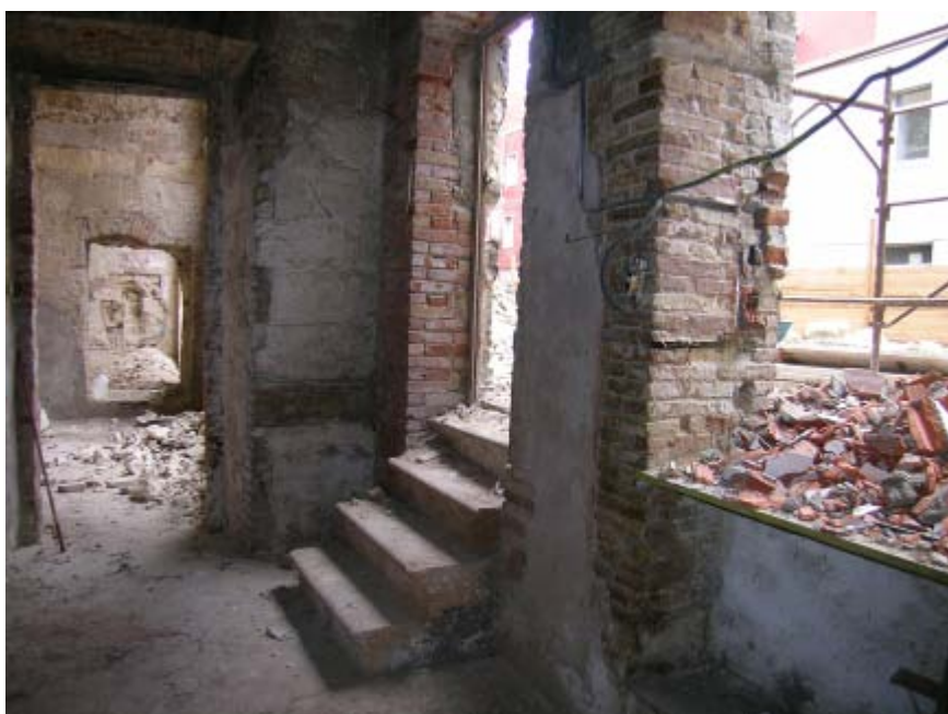
Figure 7-8-9. Lo smuramento delle cappelle (figure 7-8), avvenuto nel 2007, ha permesso nuove indagini sul rudere della chiesa ed una nuova percezione del monumento. Nella figura 9 (in basso) la Sacrestia, posta in un livello inferiore rispetto a quello del Presbiterio (foto M.C.).
