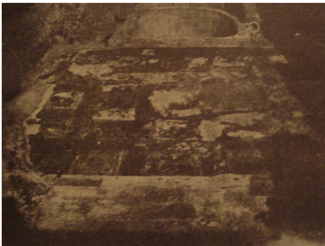
Fig. 12. Cagliari, Resti di strutture termali, foto (da Taramelli 1909).
