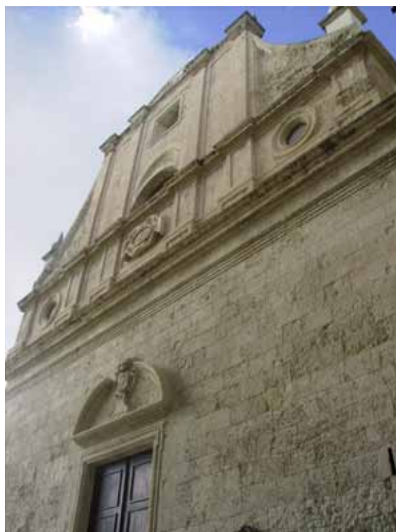
Fig. 8. Cagliari, Chiesa di Santa Croce. Veduta di scorcio del prospetto principale dalla Via Corte d'Appello (foto dell'autore)
