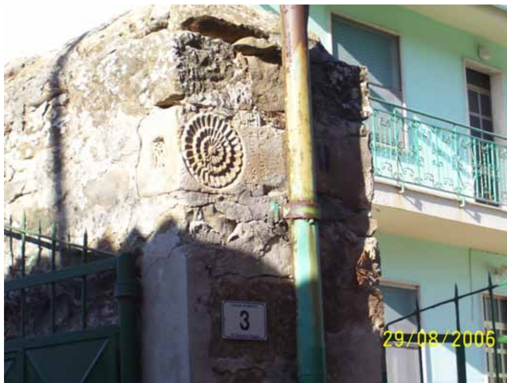
Fig. 4. Panoramica del pilastro murato
