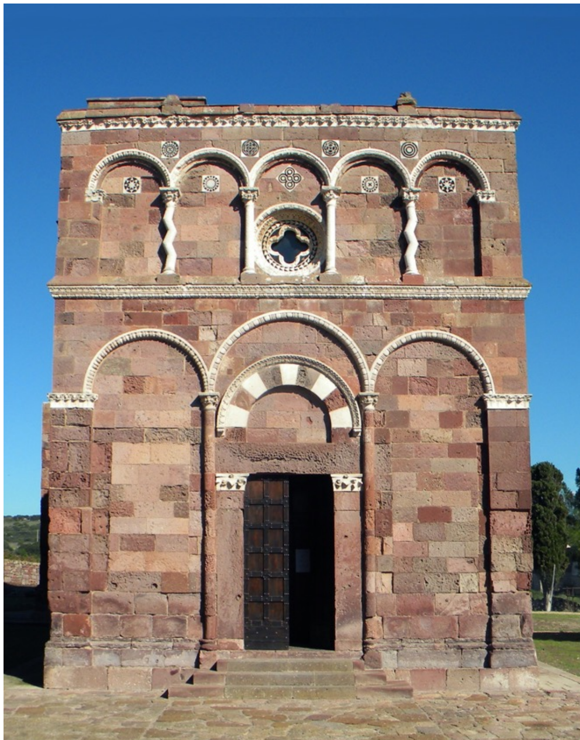
Fig. 1 Tergu (SS), Facciata della Chiesa di Santa Maria di Tergu.
