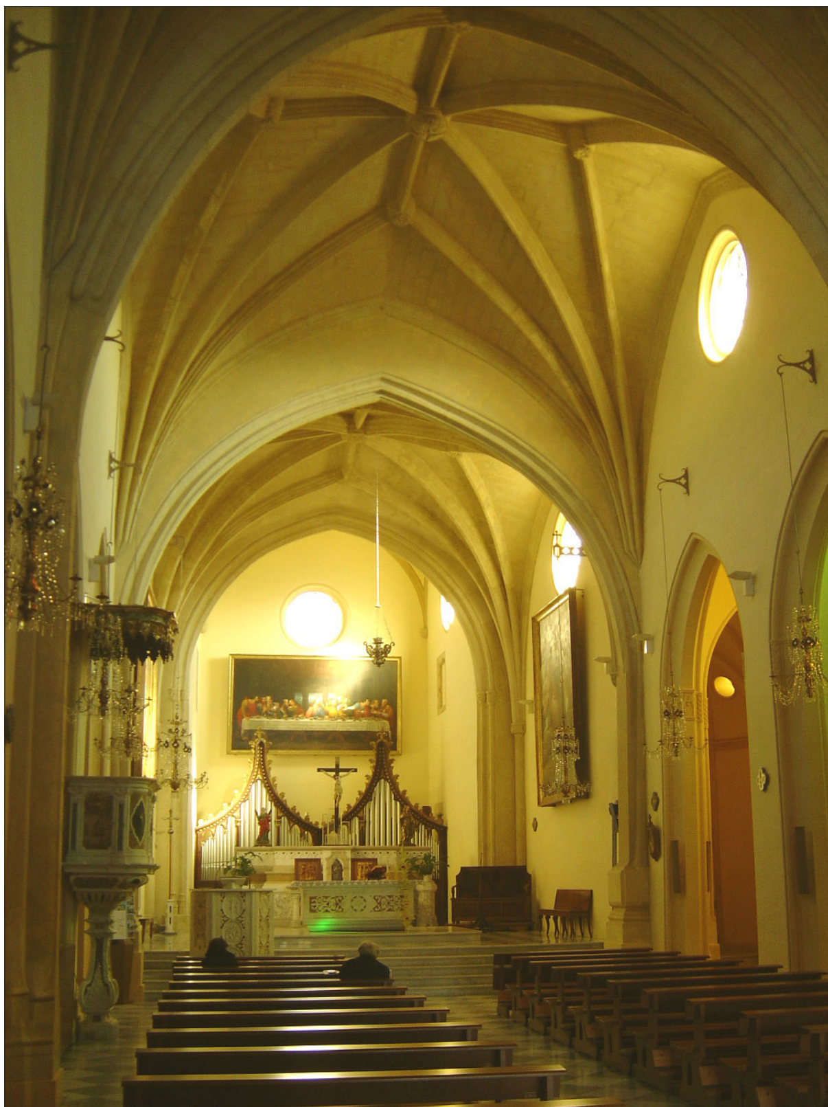
Fig. 7. Cagliari, Parrocchiale di Sant'Eulalia, interno, ricostruzione dalla metà del '500. La parrocchiale di Sant'Eulalia è uno degli esempi più interessanti dell'architettura gotica sarda. Nonostante le trasformazioni introdotte alla fine del '700 e nei primi decenni del '900, la chiesa conserva intatta la sequenza di crociere stellari lungo la navata, evidente applicazione dell'avanguardia castigliano-leonense (proprietà immagine dell'autore).
