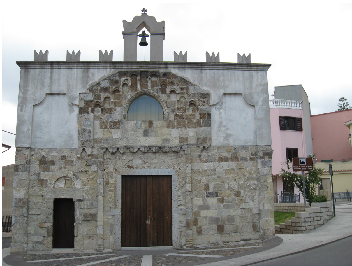
Fig. 10. Guspini, chiesa di Santa Maria, facciata (foto C. Nonne).
