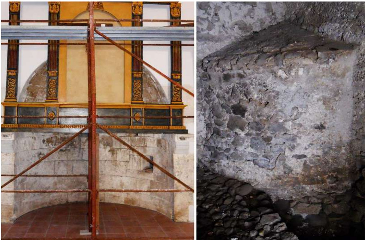
Fig. 4. Intradosso ed estradosso absidale.
