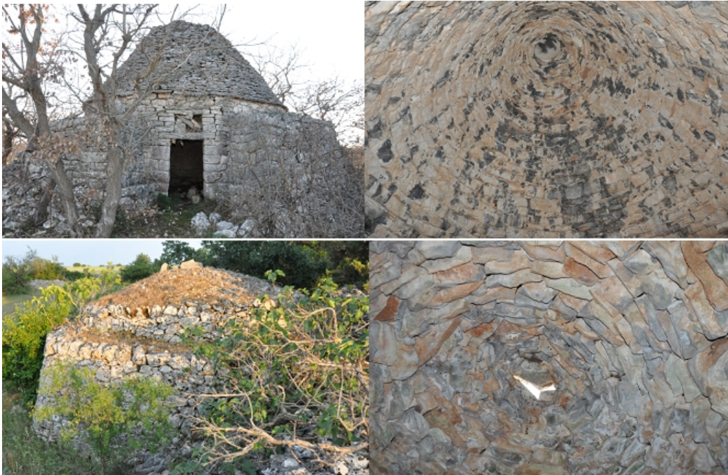
FIG 2: (in alto a sinistra) Capanna in pietra a secco dell'agro di Altamura (contrada Parco La Mena) che mostra come le chiancarelle siano state riservate per la copertura esterna, mentre la tholos interna - h 548 m - è edificata con conci di medio spessore (in alto a destra); (in basso a sinistra) capanna con copertura "a tumulo" della stessa contrada della precedente, che mostra al contrario come le lastre sottili siano state riservate per la copertura dell'ambiente interno - h 265 m - (in basso a destra), mentre l'esterno è ricoperto da ghiaia e terriccio. Foto di M. Miosi
