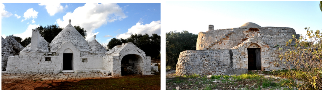
FIG 3: Due estetiche locali a confronto: (a sinistra) ogni ambiente interno viene estradossato all'esterno in un cono come in questo complesso di trulli della campagna di Francavilla Fontana; (a destra) a parte la cupoletta centrale, i due ambienti laterali sono nascosti dal gradone in questa casedda dell'agro ostunese..Foto di M. Miosi.
