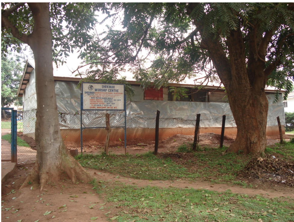
FIG. 2: Shekinah Worship Center, Kampala. Foto di A. Gusman, 2010 (la struttura è stata demolita nel 2013 e ricostruita in mattoni in un altro luogo).
