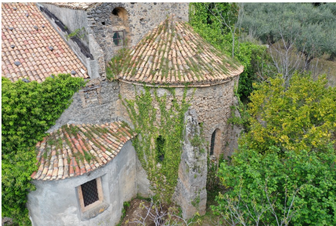
Fig. 8. Fiumefreddo Bruzio (CS), abbazia di Santa Maria di Fontelaurato, veduta area delle absidi (foto dell'A.).
