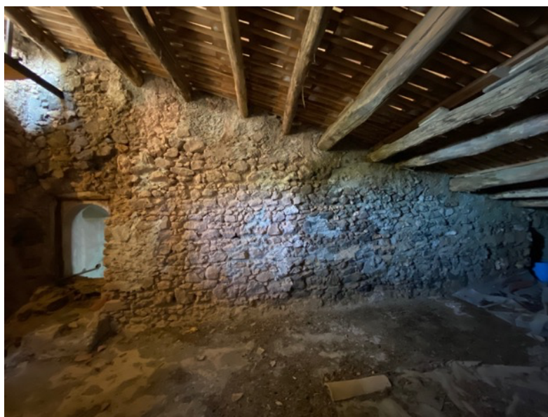
Fig. 11. Fiumefreddo Bruzio (CS), abbazia di Santa Maria di Fontelaurato, interno del sottotetto del vano sud (foto dell'A.).
