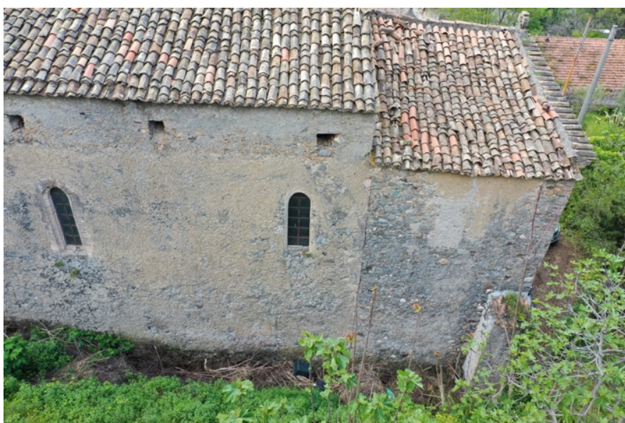
Fig. 10. Fiumefreddo Bruzio (CS), abbazia di Santa Maria di Fontelauro, veduta dell'attaccatura tra il portico e il corpo longitudinale (foto dell'A.).
