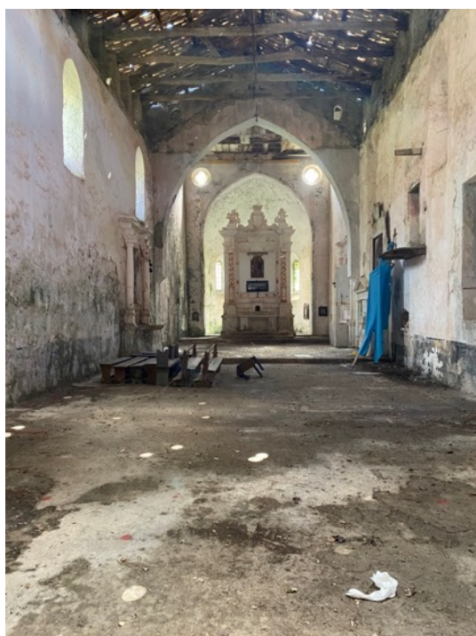
Fig. 6. Fiumefreddo Bruzio (CS), abbazia di Santa Maria di Fontelaurato, veduta dell'interno (foto dell'A.).
