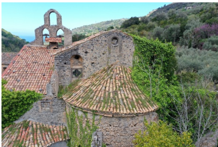
Fig. 13. Fiumefreddo Bruzio (CS), abbazia di Santa Maria di Fontelaurato, veduta area del sistema di bucatore della parete di fondo (foto dell'A.).
