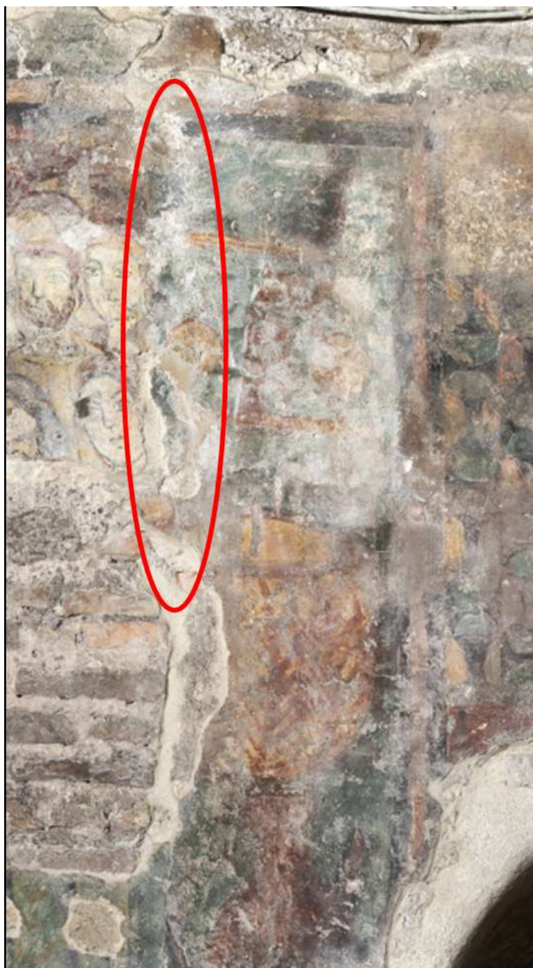
Fig. 10. Roma, San Clemente, dislivello d'intonaco (area cerchiata in rosso) a sinistra della nicchia (foto originale © Domenico Ventura con successiva elaborazione dell'A.).
