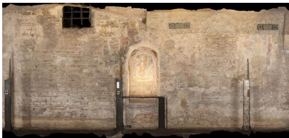
Fig. 2. Roma, San Clemente, tratto del muro perimetrale nord che include la nicchia e i due pannelli dipinti ai suoi lati. L'immagine è frutto di un rilievo fotogrammetrico svolto a luglio 2023 con l'ausilio del prof. Giorgio Fornetti e dell'attrezzatura del Laboratorio di diagnostica e tecnologia dei beni culturali LM dell'Università di Roma Tor Vergata.
