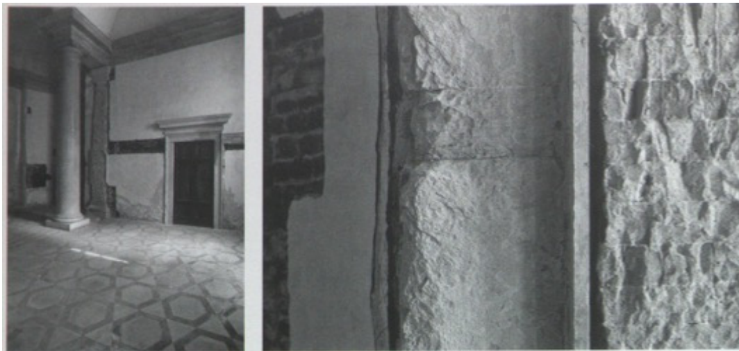
Fig. 8. Venezia, Sacrestia del Convento della Carità , foto con parasta parzialmente denudata del rivestimento lapideo e corpo laterizio a vista (da Piana 2011).
