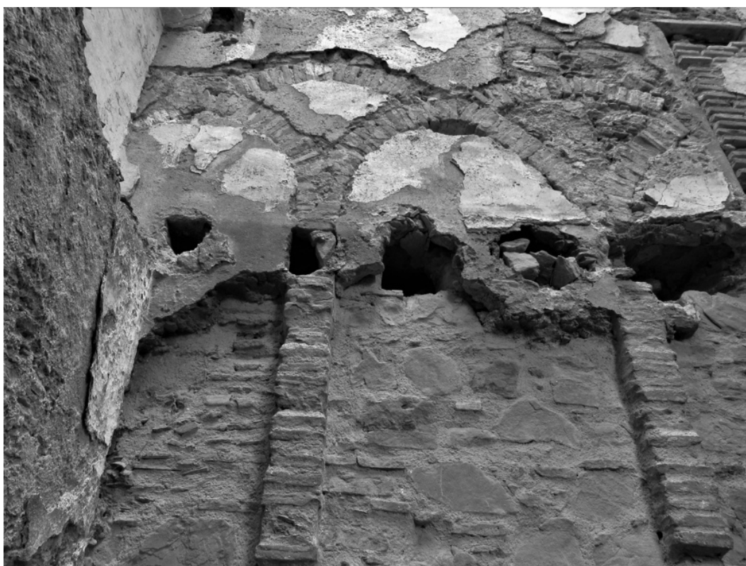
Fig. 4. Mili San Pietro (ME), Santa Maria, fiancata meridionale , archi intrecciati già inglobati nel corpo di fabbrica a pianta grosso modo quadrata della tarda età moderna addossato alla chiesa (foto dell'A.).
