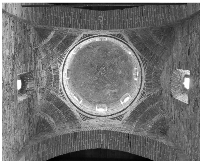
Fig. 13. Casalvecchio Siculo (ME), Santi Pietro e Paolo d'Agro, sistema di sostegno della cupola occidentale (foto dell'A.).
