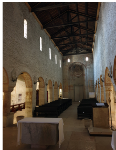
Fig. 6. San Giorgio di Valpolicella (Vr) chiesa di San Giorgio, interno.
