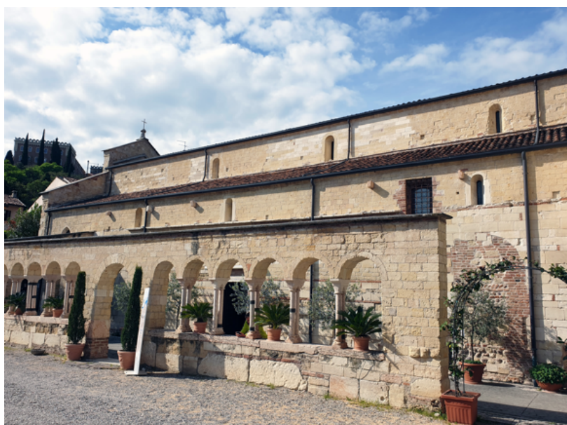
Fig. 7. Verona, chiesa di San Giovanni in Valle, prospetto meridionale .
