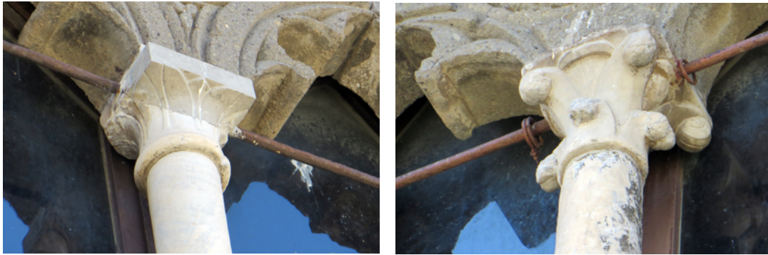
Figg. 2a e 2b. Tarquinia, Palazzetto di Santo Spirito, capitelli duecenteschi reimpiegati nelle bifore della facciata (foto dell'A.).
